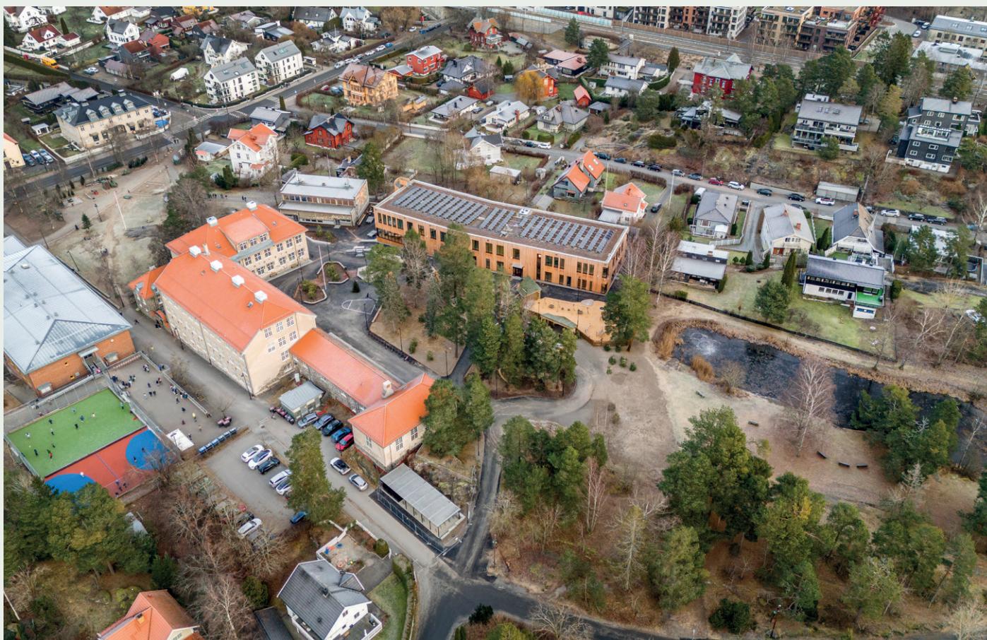
Like ved byggeplassen på Nordstrand ligger Andersendammen, som blant annet er hjem til to rødlistede froskearter.
