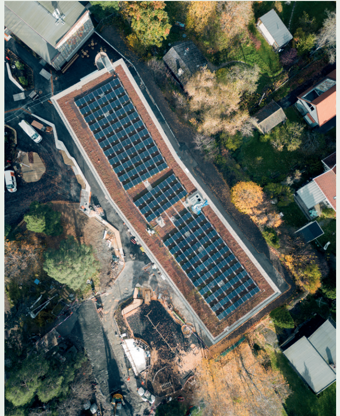
På taket på nybygget er totalt 300 kvadratmeter med solcellepaneler installert. Solcelleanlegget har en produksjonskapasitet på 61.000 kilowattimer per år. Foto: Stine Prøitz Jørgensen / Varden Entreprenør
