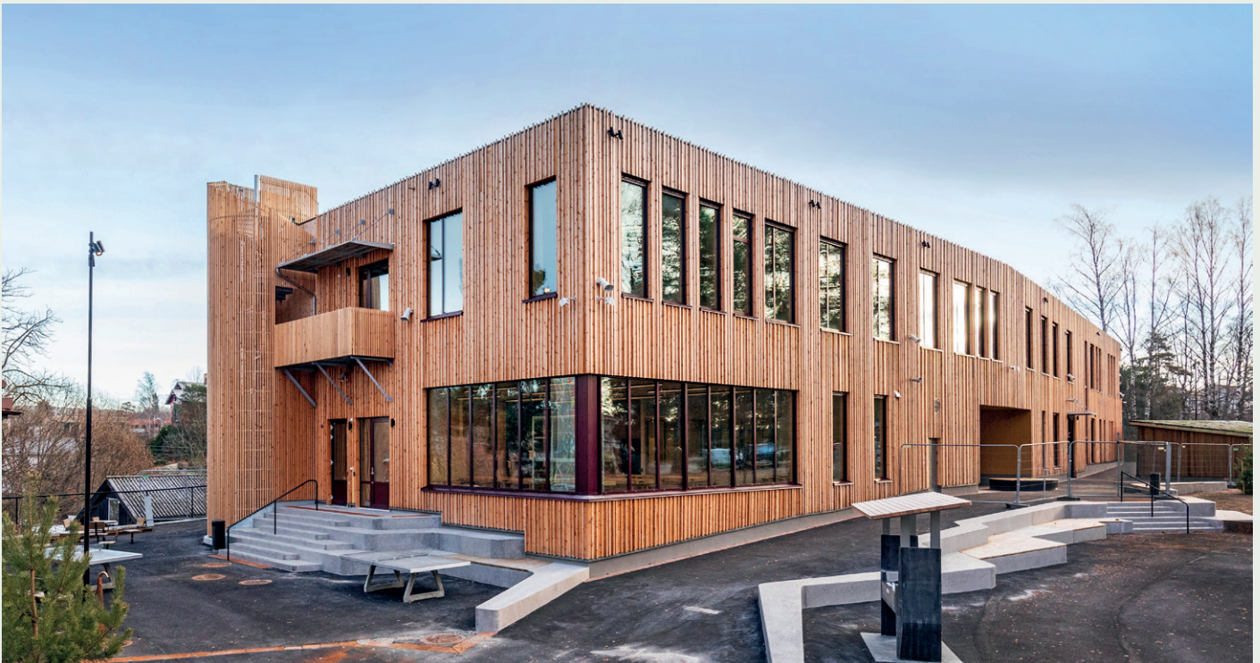
Foto: Hanne Bruland / Varden Entreprenør
