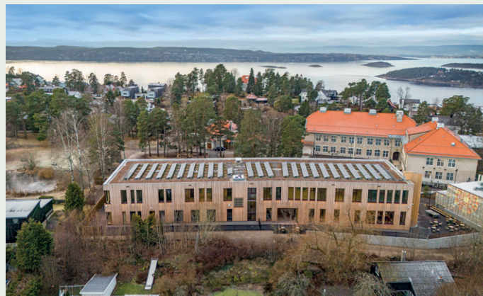
Foto: Hanne Bruland / Varden Entreprenør
