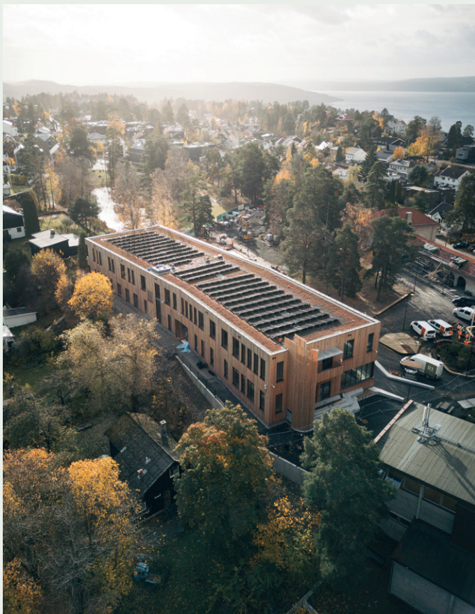
Det nye trebygget ligger fint i terrenget, omkranset av trær. Foto: Stine Prøitz Jørgensen / Varden Entreprenør
